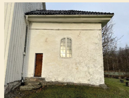
Slitt overflate på middelalderkoret.
